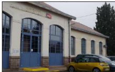
Les travaux visant à l'aménagement des installations de la gare de Baccarat débuteront en mai prochain. Photo ER/Adeline ASPER
