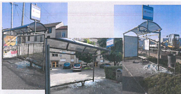
De nombreux actes de vandalisme sur le mobilier urbain recensés entre le 08 août et le 1 er septembre 2021, avec dépôt de plainte effectué par le PETR du Pays du Lunévillois.
