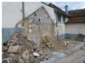
démolition de l'ancienne chaufferie par l'entreprise Partégo Soléfor de Blamont. Photo ER
