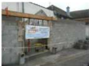
Les travaux de la chaufferie et l'installation de la chaudière ont permis de faire travailler 2 entreprises locales. Photo ER
