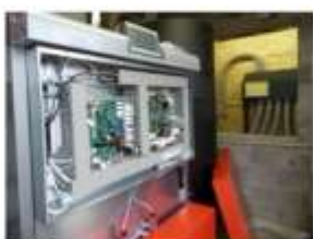
Mise en service et réglage de la nouvelle chaudière à pellets. Photo ER
